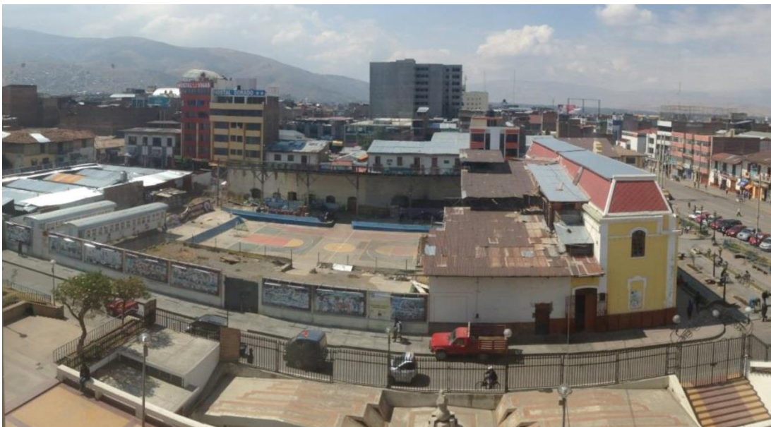
Figura 100. Vista aérea del terreno y fachada existente
