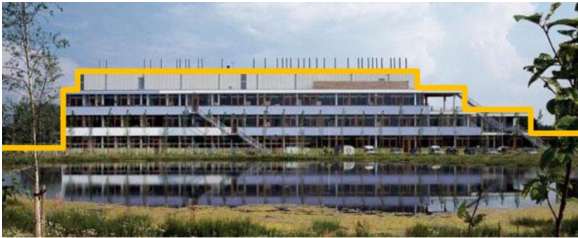
Figura 50. Fachada este del instituto
