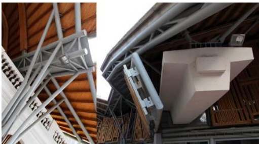
Figura 64. Estructura de la cubierta
