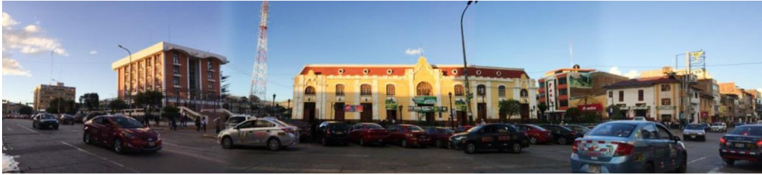
Figura 98. Vista frontal Fachada existente
