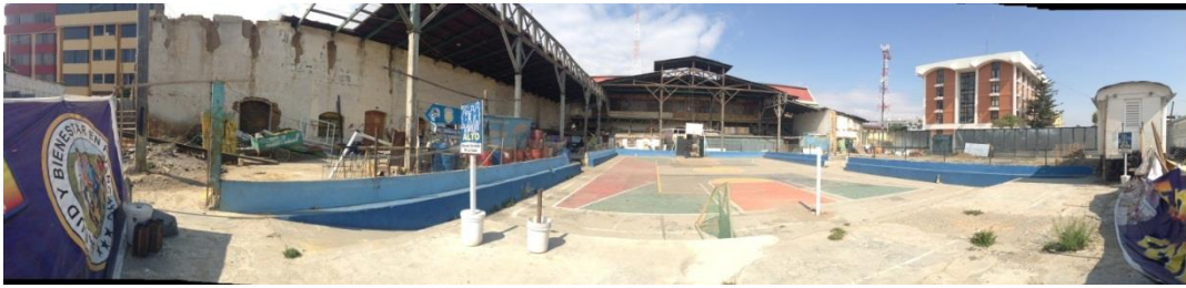
Figura 84. Vista desde el interior hacia la plaza Huamanmarca
