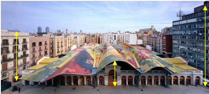
Figura 63. Fachada principal Mercado Santa Caterina
