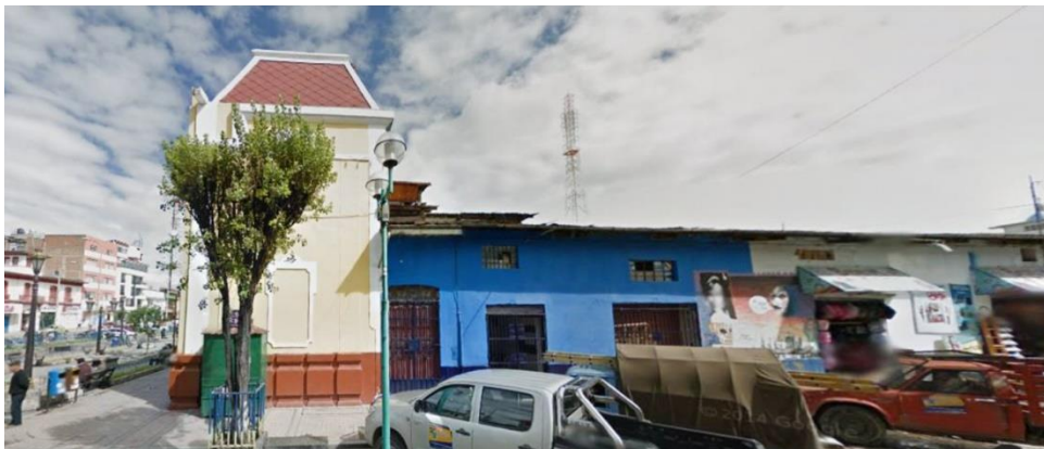
Figura 107. Vista lateral del terreno – Jr. Piura
