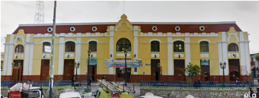
Figura 105. Vista frontal del terreno – fachada existente
