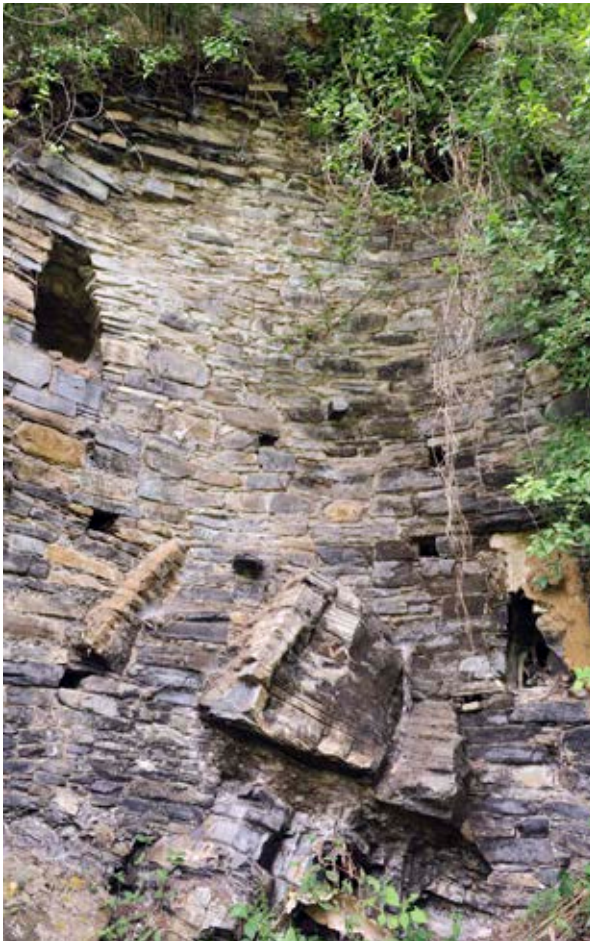
Figura 26. Los materiales de la construcción son piedras y tajas de pizarra que fueron entretejidas con la roca natural. Fotografía: © Ángela Brachetti-Tschohl.
